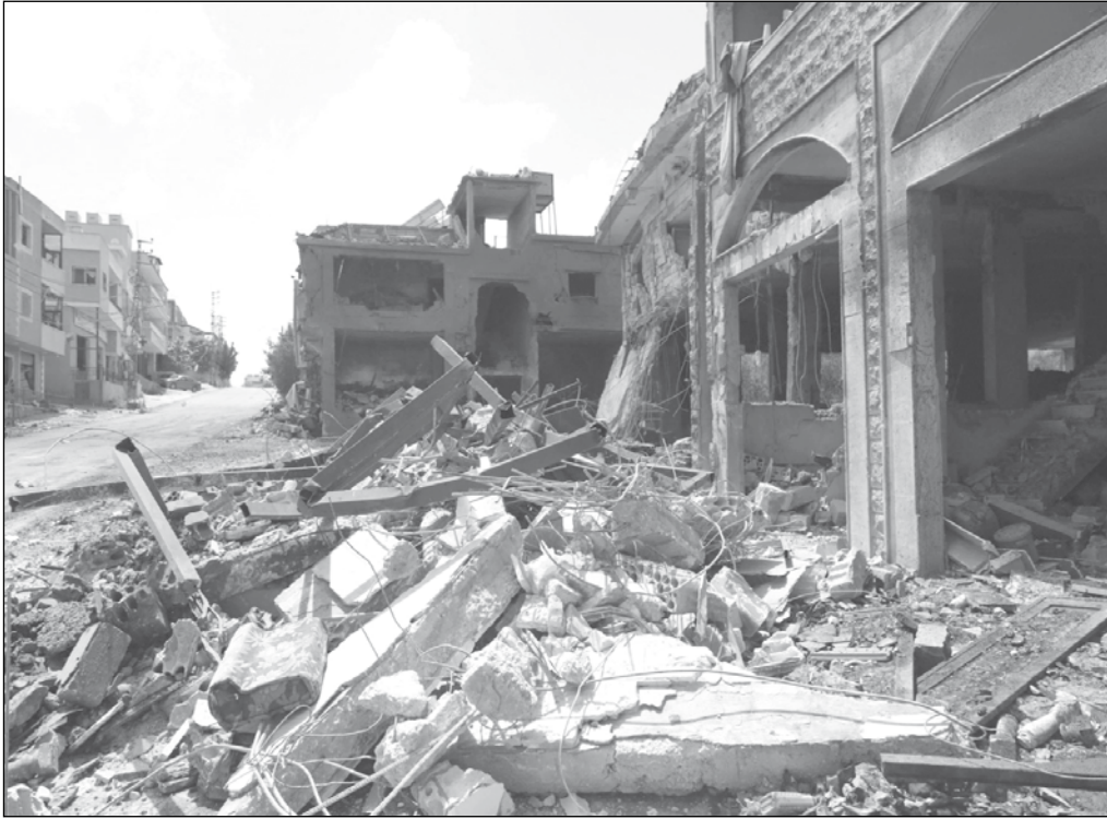
اضرار تصيب المنازل في جنوب لبنان. المصدر: الشرق الاوسط
