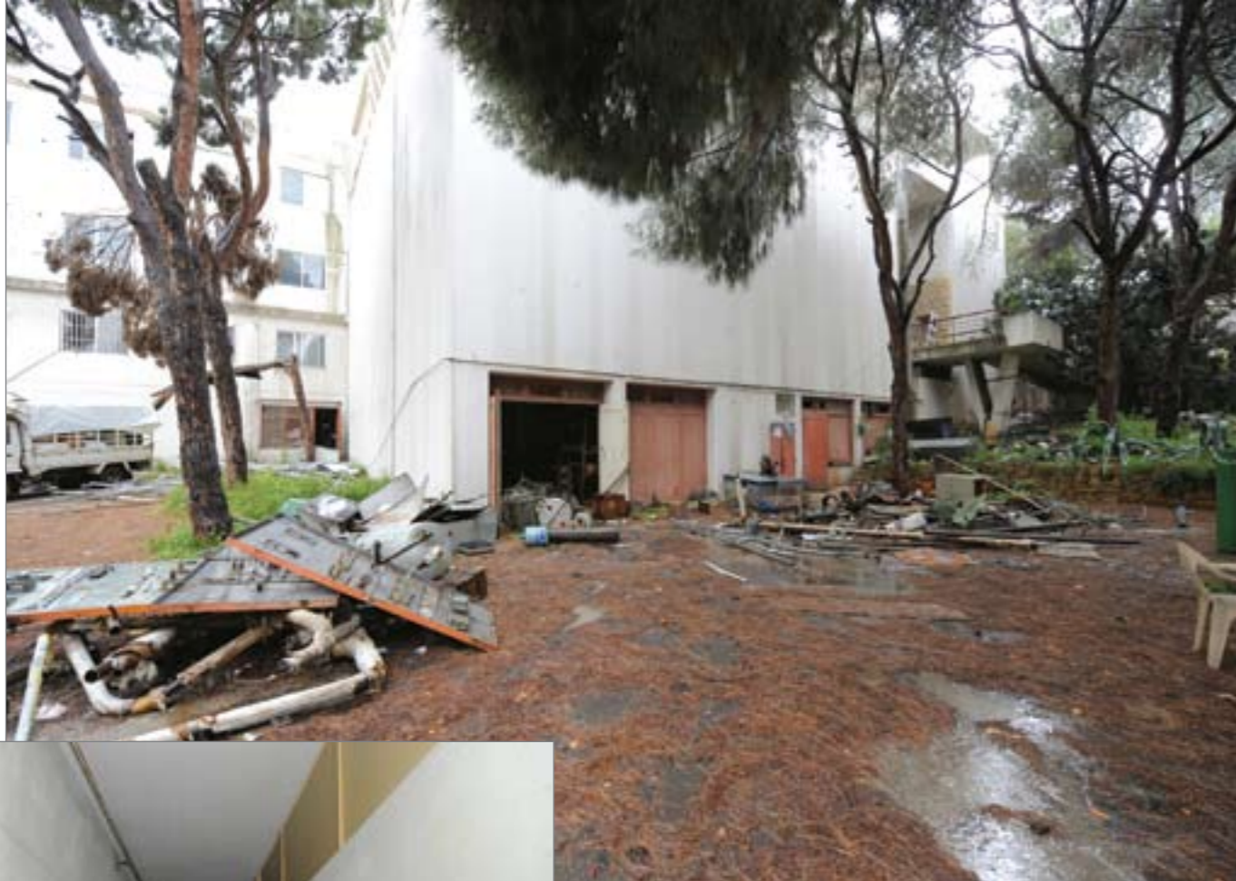
Cette photo représente l'arrière-cour du bâtiment principal. La construction qu'on y voit donne l'impression d'une extension du bâtiment principal construite plus tard. En plus de l'entrée visible sur cette photo, cette construction communique avec le bâtiment principal par un couloir interne (image de gauche).
